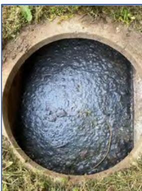
Présence d'une couche en surface de graisses oxydées d'aspect brun/noir et partiellement solidifiée
